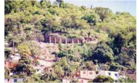
Contraforte Atirantado no Morro São Benedito - 1996
