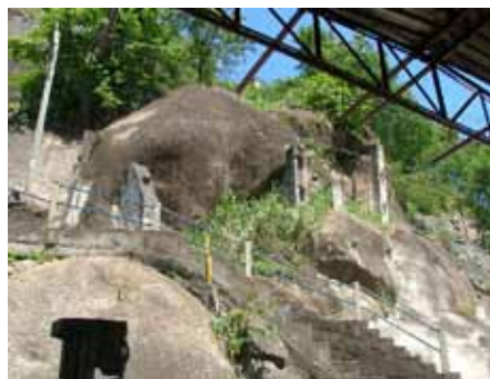
Contraforte Atirantado da Av. Leitão da Silva, 633 no Morro do Jaburu
